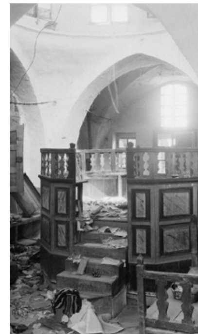
Разрушенная и оскверненная синагога «Авраам авину»
